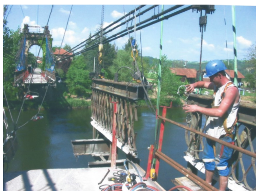
Démantèlement du pont (photo Benazeth)
